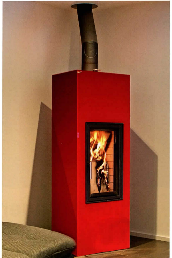
Der Standort an der Aussenwand ist für den Ofen nicht ideal. Zum Heizen in der Übergangszeit reicht die Wärmeverteilung trotzdem.
