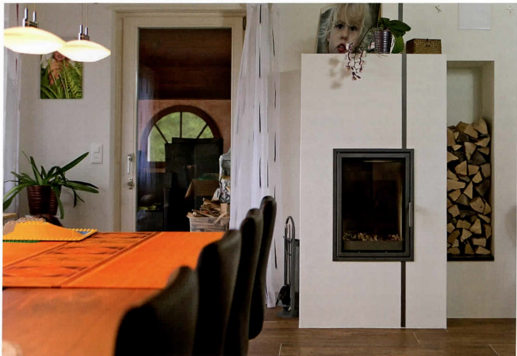
Die Speicherkapazität dieser Wohnraumfeuerung reicht für rund 30 Stunden. «Endlich richtige Wärme in der Stube», lautet der Kommentar der Bauherrschaft.
