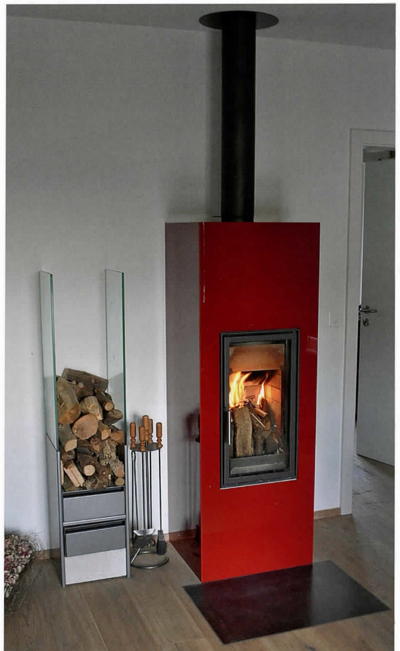
Dieser Speicherofen wird vor allem in der Übergangszeit als Wohnraumheizung genutzt. Seine kecke Farbe und die schlichten Formen machen ihn zu einem stilvollen Gestaltungselement des Wohnzimmers. Die Wärmeabgabe eines Abbrandes dauert rund 20 Stunden.
